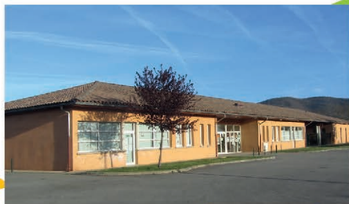
ECOLE Briques, ciment et enduit.
