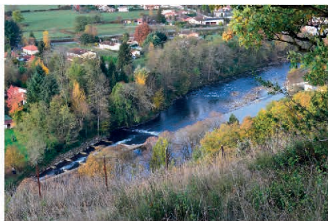
Passé à poissons sur l'Ariège
